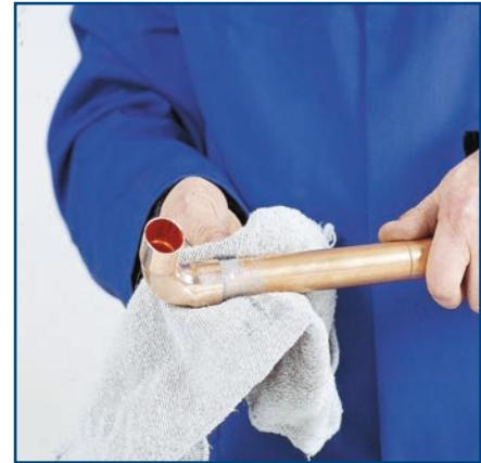
Pour les flux de brasage tendre, l'élimination peut se faire par exemple avec un chiffon humide, pour les flux de brasage fort, en raison de leur caractère vitrifié, par exemple avec une brosse en laiton.
