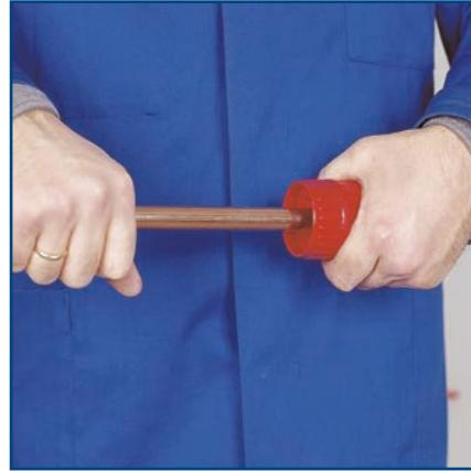
Les tubes doivent ensuite être soigneusement ébavurés à l'extérieur et à l'intérieur. Les tubes à l'état de résistance 'souple' doivent en outre toujours être calibrés avant la poursuite du montage.
