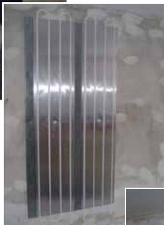
3. Nächste Montageleiste einhängen und montieren. Anschließend Wandheizelemente an den Heizungs-kreislauf anschließen.
