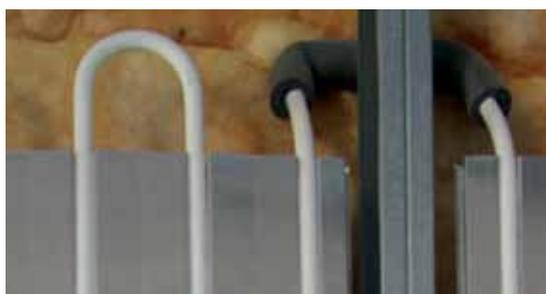
Durchführungen durch Ständer mit weichfedern- dem Dämmstoff polstern.
