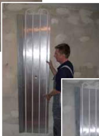
2. Wandheizelement in die seitliche Verzahnung einhängen und anschließend mit einer Schraube durch die vorgebohrte Lochung fixieren. Keine weitere Befestigung des Wandheizelementes durch Schrauben!
