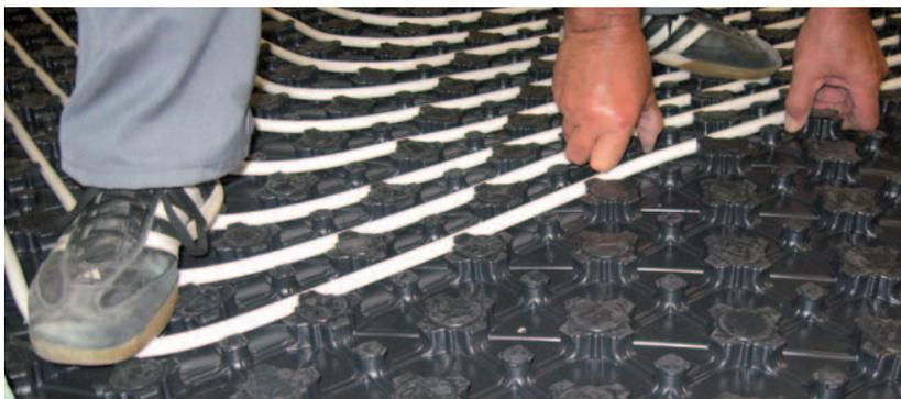
Nach dem Ausrichten der Rohre: die notwendige Estrichdicke kann eingebaut werden.
