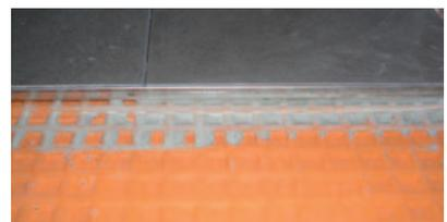
Für die Ausbildung von Fugen im Oberbodenbelag gibt es geeignete Fugenprofile. Die Empfehlungen zu den Feldgrößen lehnen sich an die früheren Fugenvorgaben für Standardestriche an. Fugen im Oberbelag sollten vorgesehen werden ab Feldgrößen  $> 40 \text{ m}^2$  und bei einem Seitenverhältnis von  $> 2:1$  oder bei extremen Versprüngen in der Fläche.
