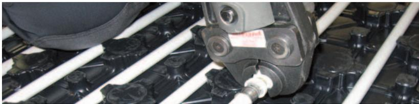
7. Nach dem Verlegen eines Heizkreises Rohre ausrichten.
