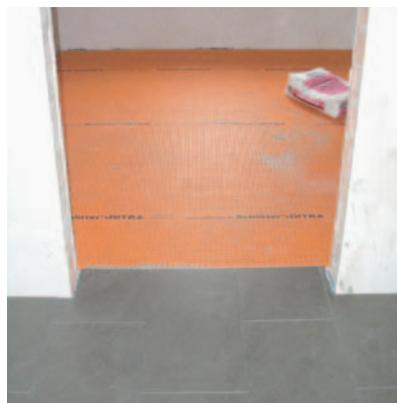
links: verlegte Entkopplungsmatte mit aufgezogenem Kleber und Fugenprofil für den Bodenbelag
